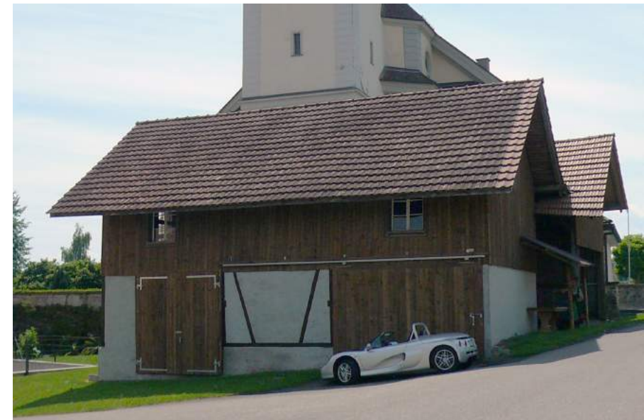
Chelematt, Ökonomiegebäude, Ansicht von NW
