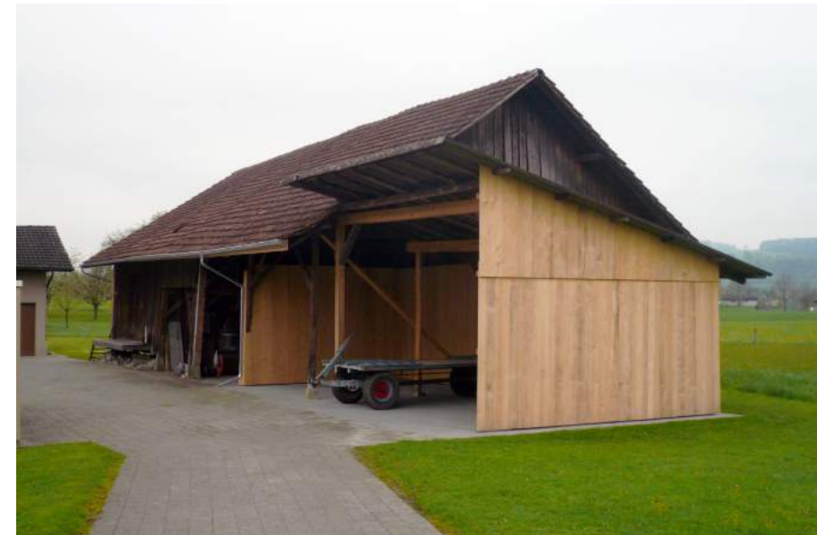
Kantonsstrasse, ehem. Torftrockenanlage und Magazin, Ansicht von N
