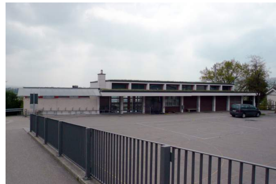
Schulhausstrasse 1, Turnhalle, Ansicht von NW
