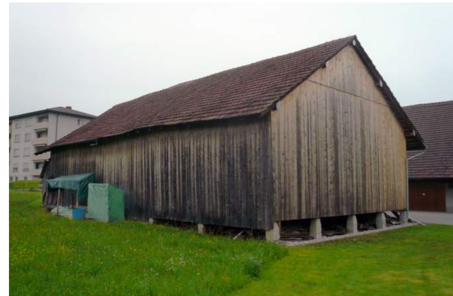
Kantonsstrasse, ehem. Torftrockenanlage und Magazin, Ansicht von S
