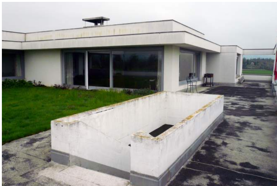
Hitzligen 5, Aussenbereich Obergeschoss, Blick Richtung O
