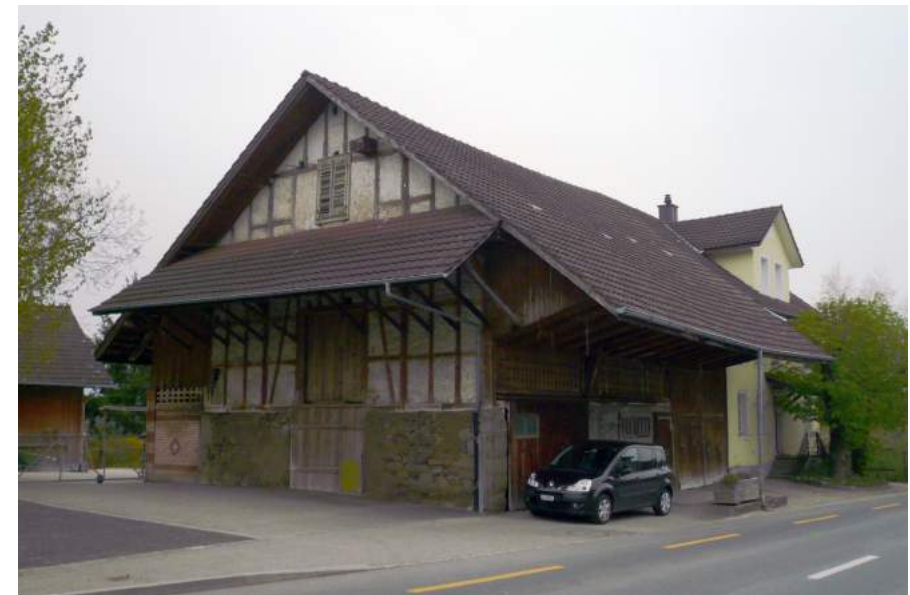
Kantonsstrasse 11, Ansicht von W
