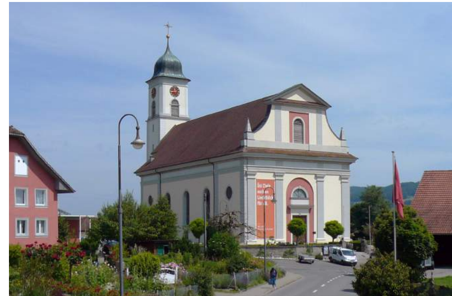
Pfarrkirche St. Stephan und St. Bartholomäus, Ansicht von SW
