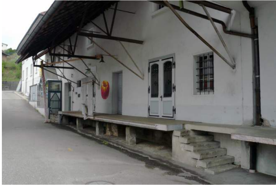
Kantonsstrasse, Mosterei Rütter, Detailansicht S-Fassade
