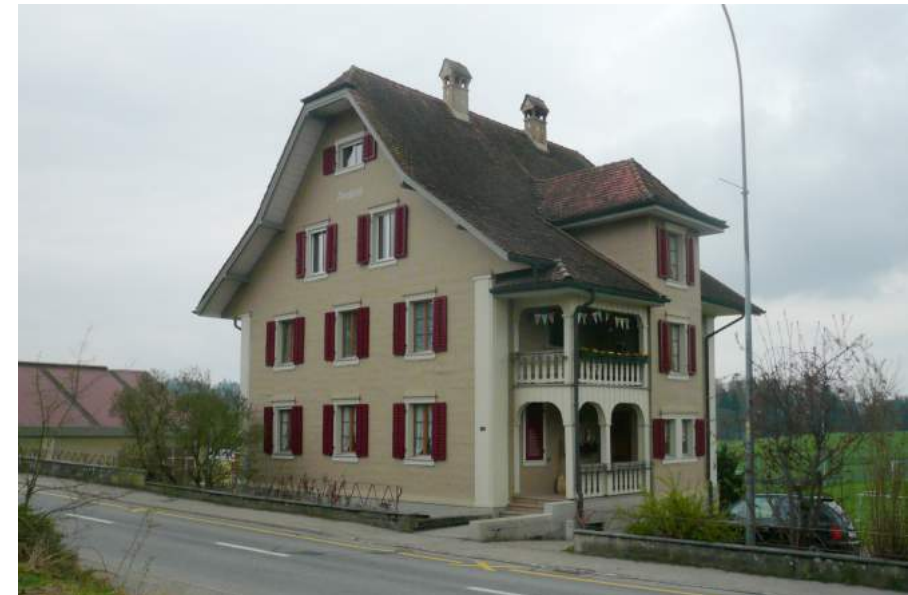
Büelstrasse 4, Ansicht von NO
