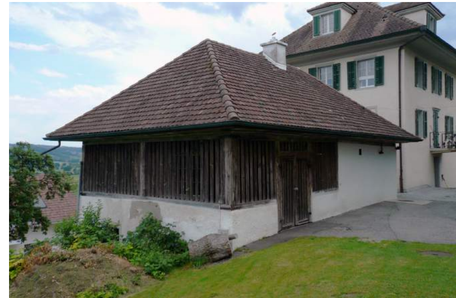
Chelerain, Ökonomiegebäude, Ansicht von NW
