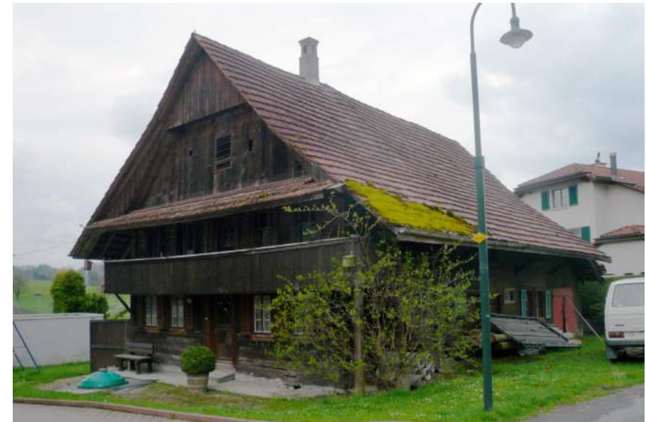
Eriswilerstrasse 3, Ansicht von NO
