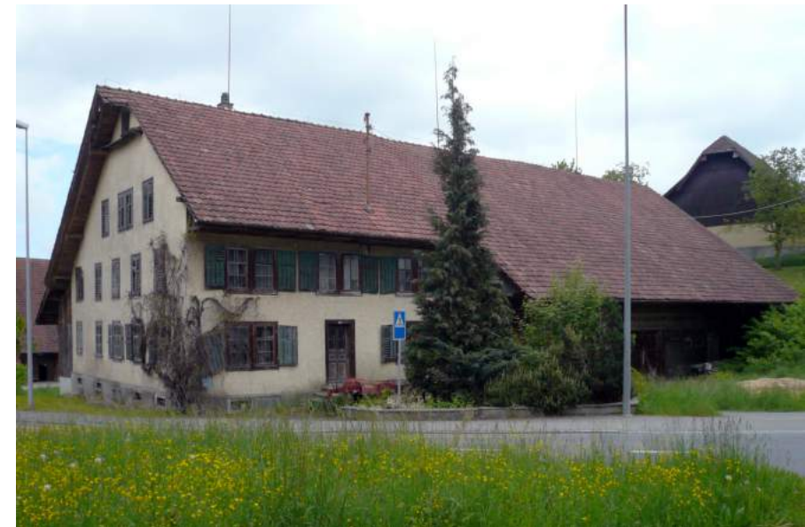
Büronerstrasse 6, Ansicht von SW
