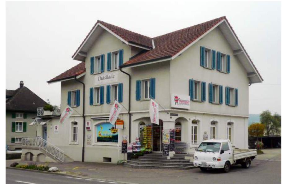
Kantonsstrasse 10, Chäsilade, Ansicht von N
