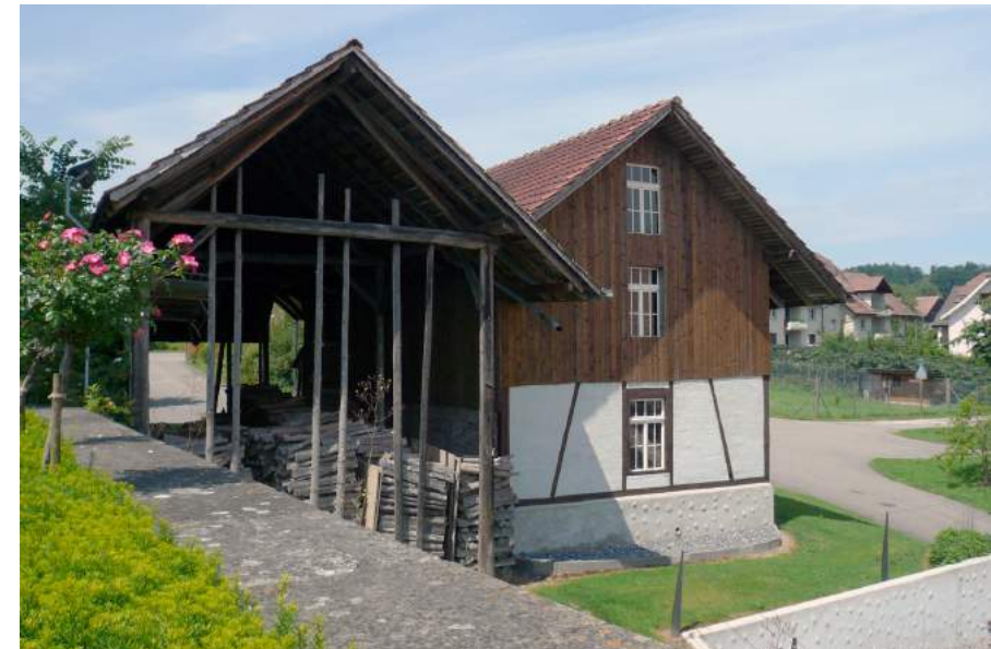
Chelematt, Ökonomiegebäude, Ansicht von O
