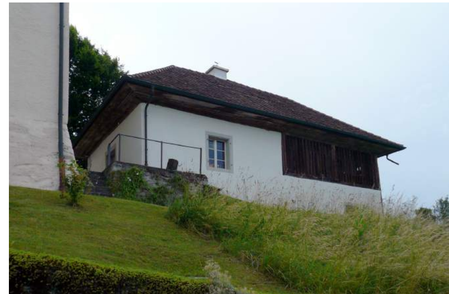
Chelerain, Ökonomiegebäude, Ansicht von SO
