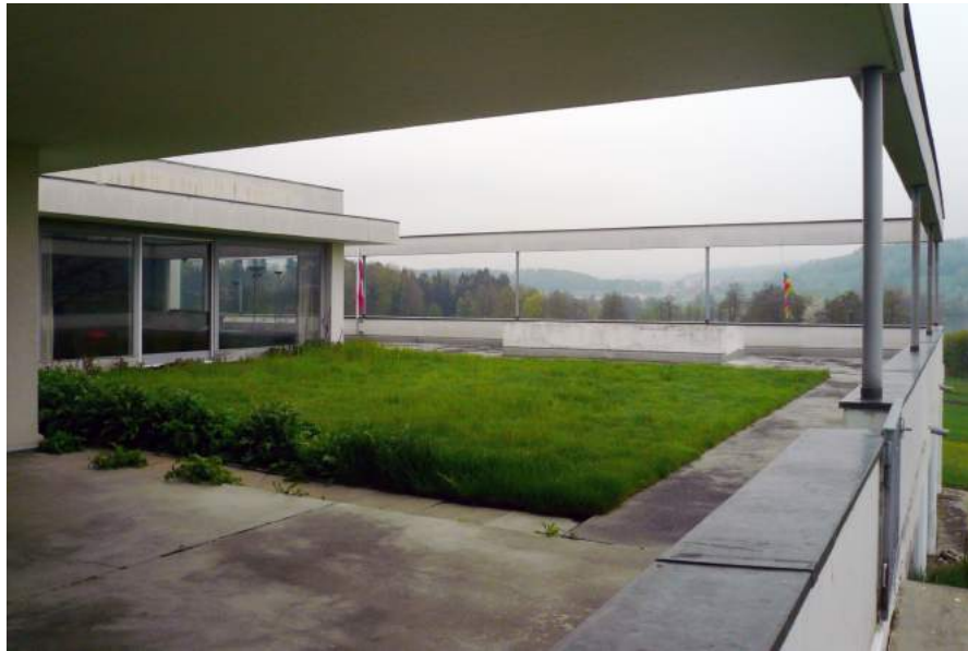
Hitzligen 5, Aussenbereich Obergeschoss, Blick Richtung S
