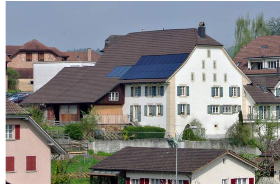
Zehntenhof, Ansicht von SO
