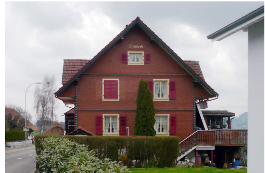
Wilihofstrasse 4, Ansicht von S
