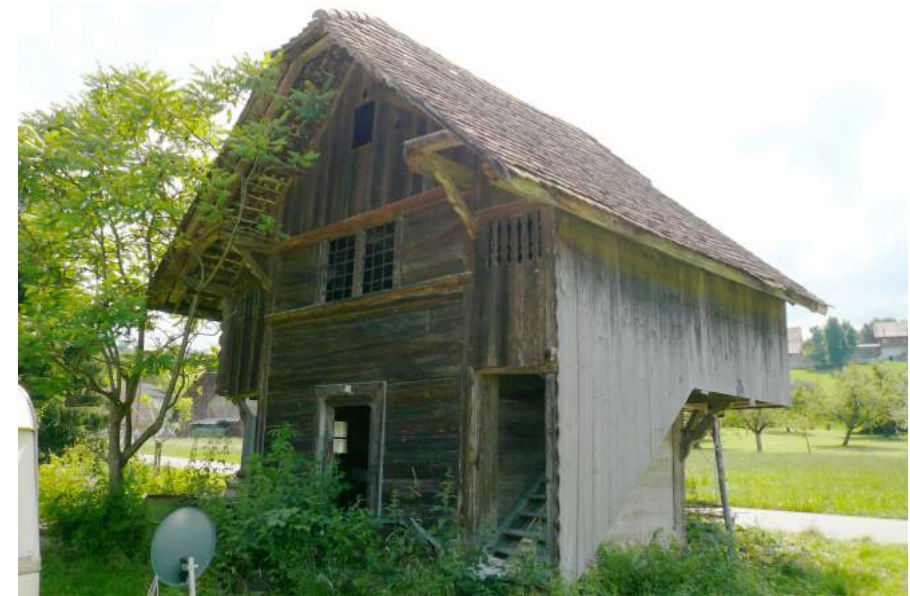
Steinholz, Kornspeicher, Ansicht von NO
