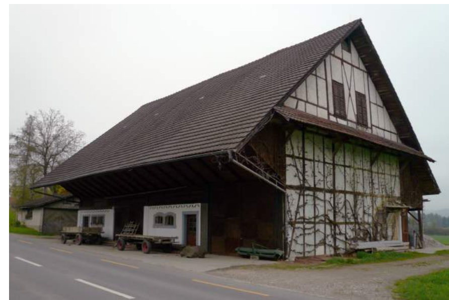
Kantonsstrasse, Scheune, Ansicht von S
