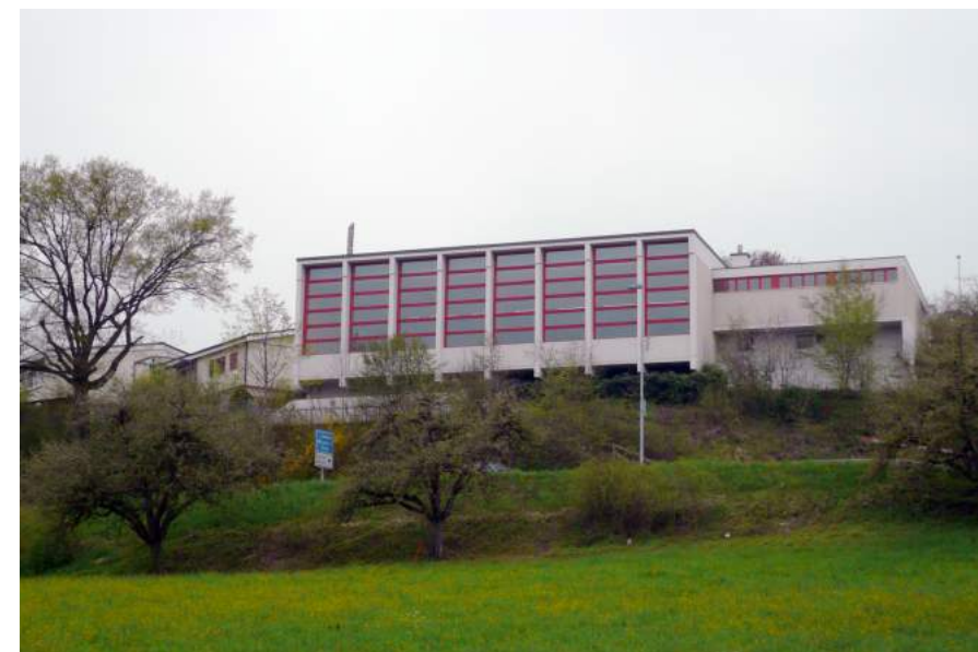
Schulhausstrasse 1, Turnhalle, Ansicht von O
