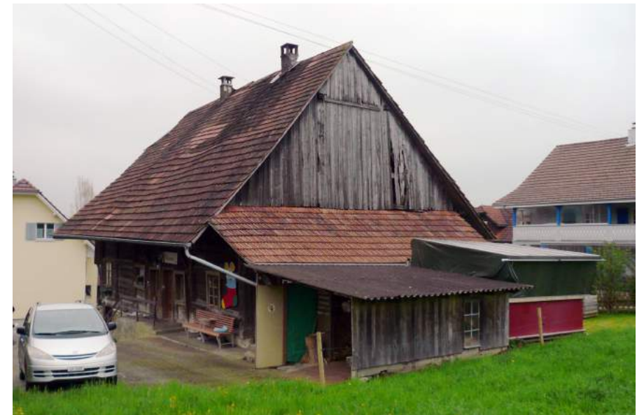
Geuenseestrasse 13, Ansicht von NW
