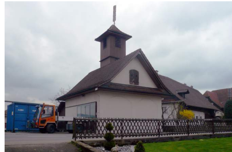
Wilihofstrasse, Feuerwehrmagazin, Ansicht von NW
