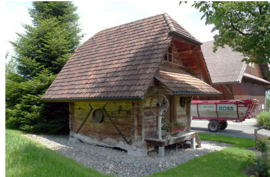
Hinterdorfstrasse, Kornspeicher, Ansicht von S
