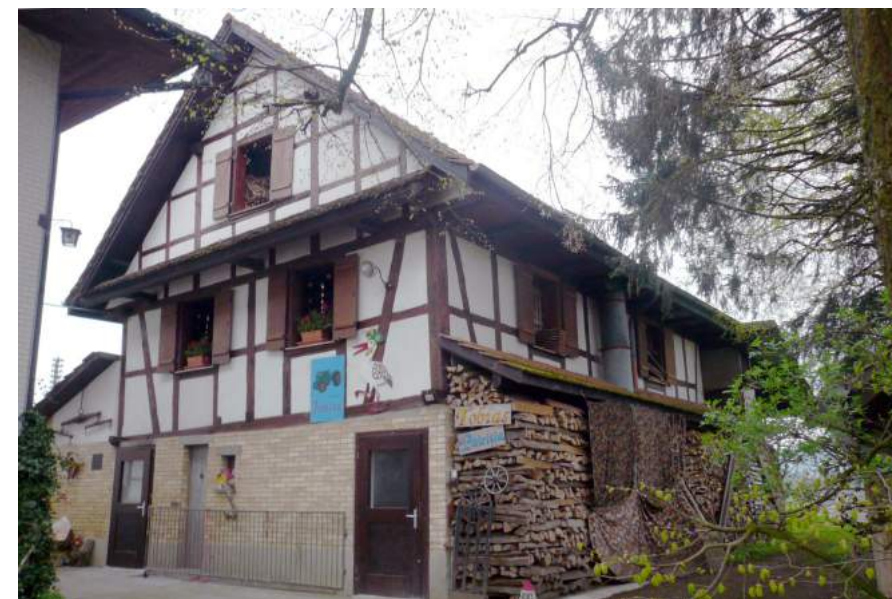
Kantonsstrasse, Ökonomiegebäude, Ansicht von N
