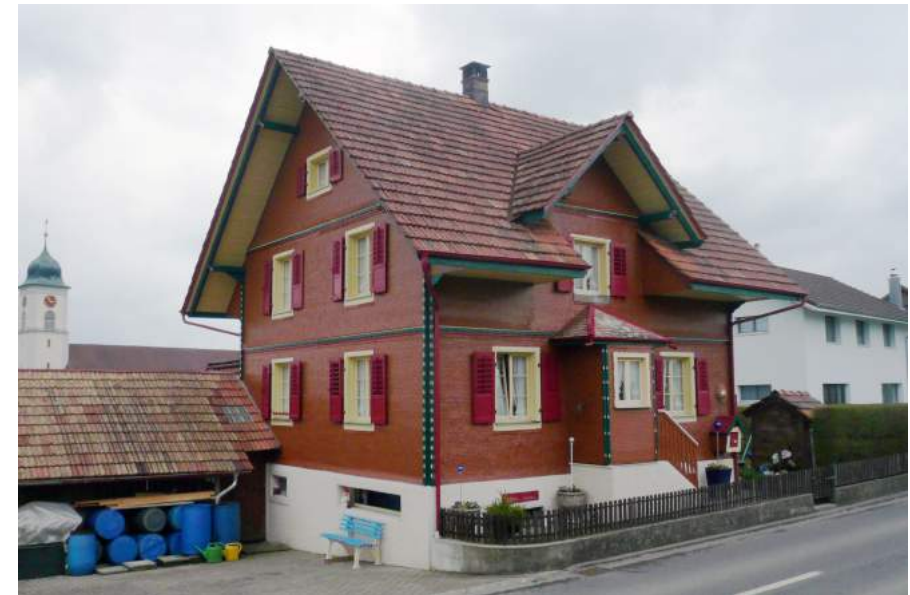
Wilihofstrasse 4, Ansicht von NW
