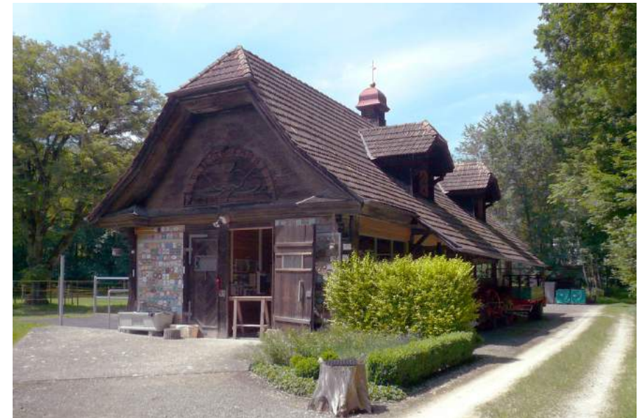
Sackmatt, Korporationshütte Sursee, Ansicht von SO
