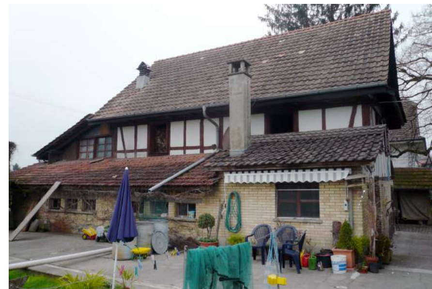
Kantonsstrasse, Ökonomiegebäude, Ansicht von SO
