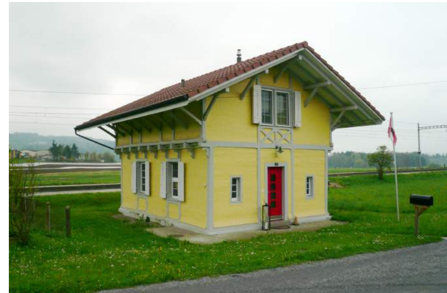
Bahnhöfli 5, Ansicht von NO
