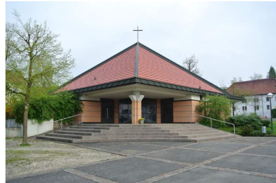
Kantonsstrasse, Kapelle St. Erhard, Ansicht von SO
