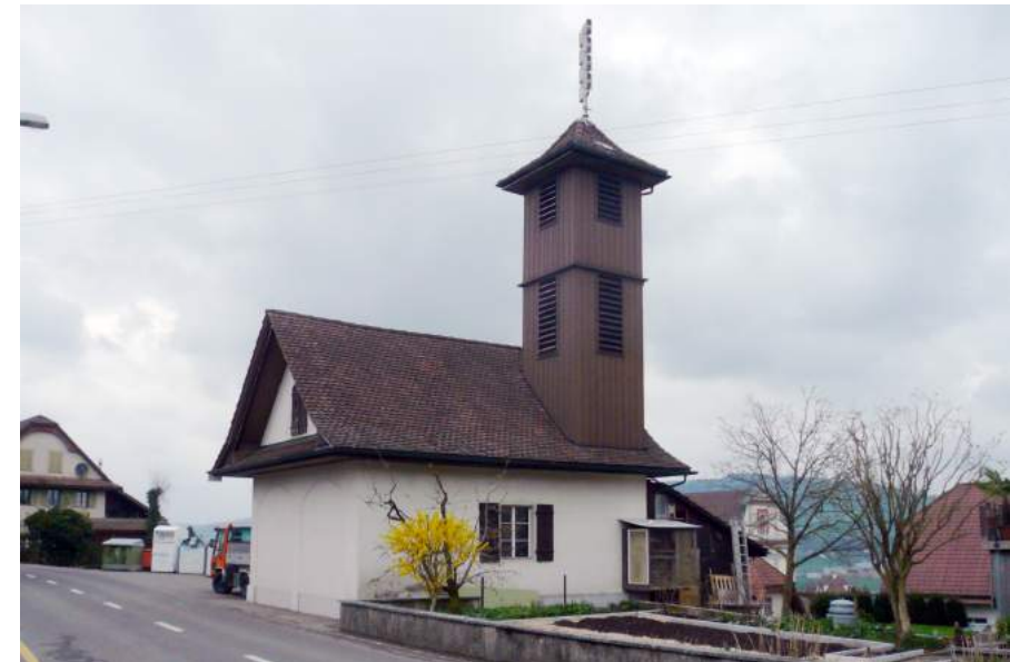
Wilihofstrasse, Feuerwehrmagazin, Ansicht von SW
