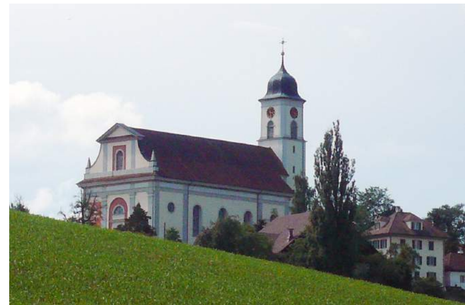
Pfarrkirche St. Stephan und St. Bartholomäus, Ansicht von SO
