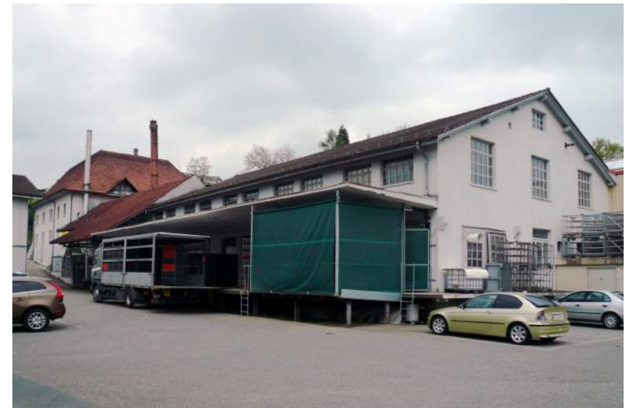
Kantonsstrasse, Mosterei Rütter, Ansicht von SO
